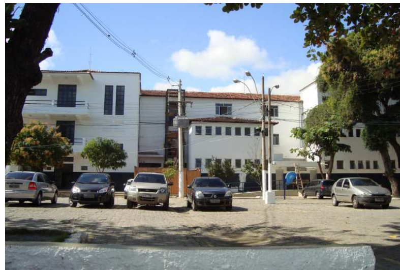
Henrique Lage: depois da obra, ainda padece com os antigos problemas.
